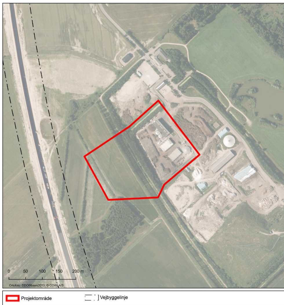
Figur 3-3 Projektområdet omkranset af rød markering. Det eksisterende anlæg er beliggende i den østlige del af projektområdet. Udvidelsen vil ske mod vest, sydvest hvor der i dag er dyrket mark.
