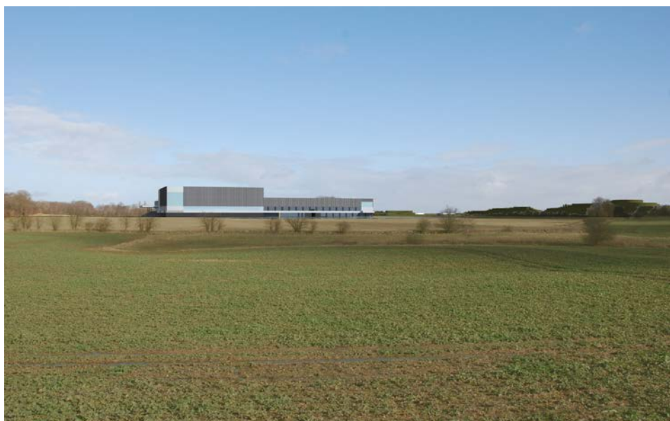
Figur 5-2: Visualisering af bygning i byggefelt A samt illustration af terrænregulering øst for byggefeltet set fra Omfartsvejen syd for lokalplanområdet.
