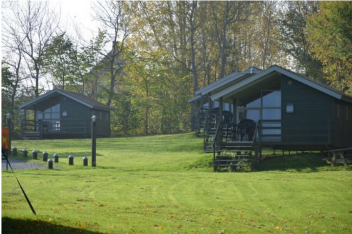
Campingpladsen har 20 campinghytter der er fordelt i to klynger, hhv. i den centrale og sydvestlige del af området.
