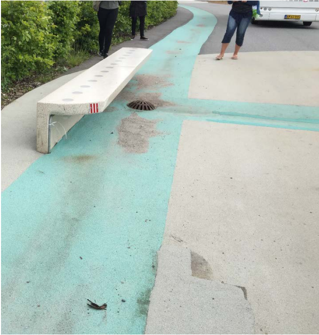
Figur 3. "Vandvenderbænk" der vender vandets retning 90 grader, og derved forhindrer at det løber ind på bagvedliggende matrikel.
