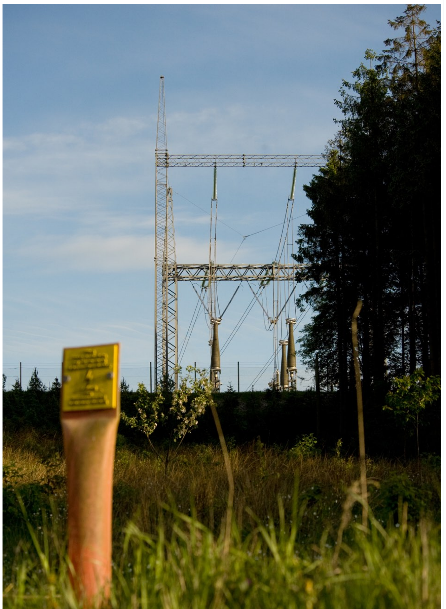
I en kabelstation føres ledningerne ned i jorden. En pæl markerer, hvor kablerne er nedgravet. Også ved jordkabler er der magnetfelter. Se eksempler i "Katalog over magnetfelter ved højspændingsanlæg".
