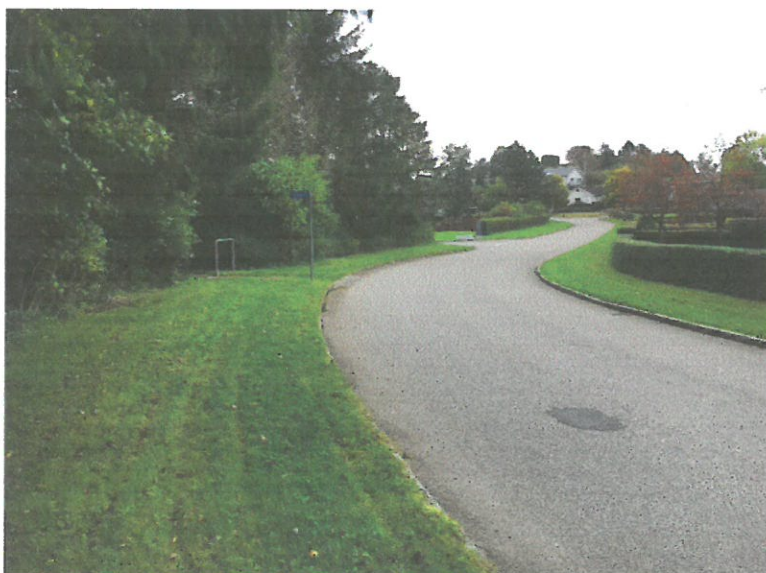
Foto nr.3 Frit udsyn mod nord, fra mulig udkørsel ved vej D
