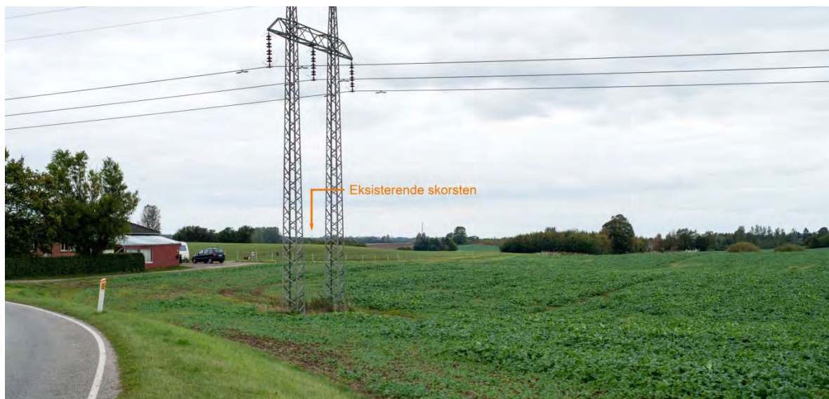
Figur 22 Eksisterende anlæg set fra Østrupvej mod nordvest (3,2 km fra projektområdet).
