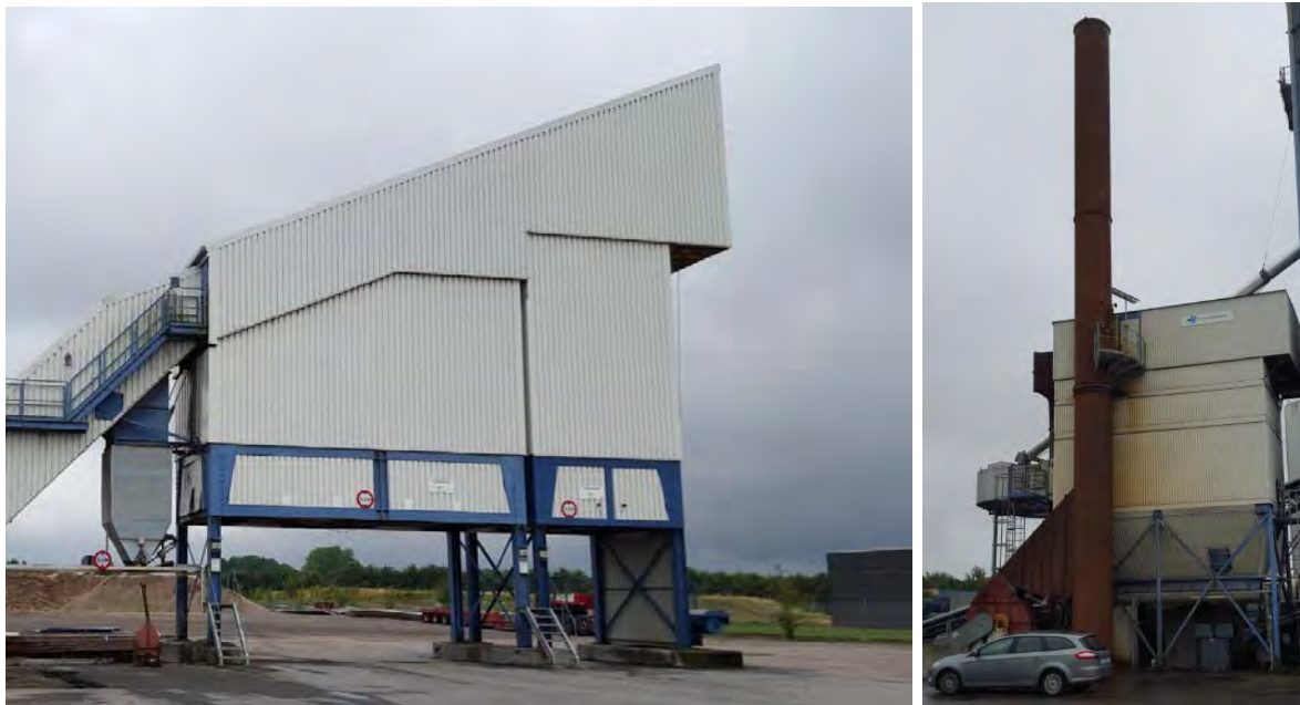
Figur 4 Eksisterende færdigvareanlæg og filter fra nedlukket asfaltfabrik på Kometvej i Horsens.
