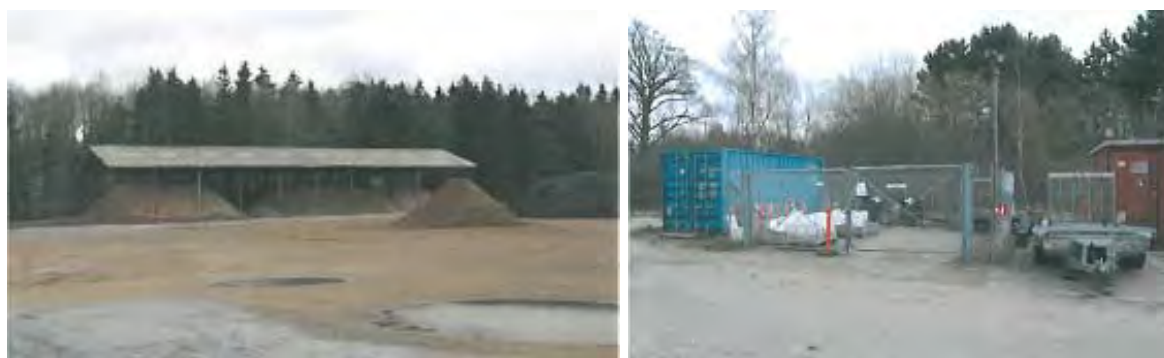
Figur 6 Eksisterende staklade og indhegning til asfaltopløsninger i Undløse.
