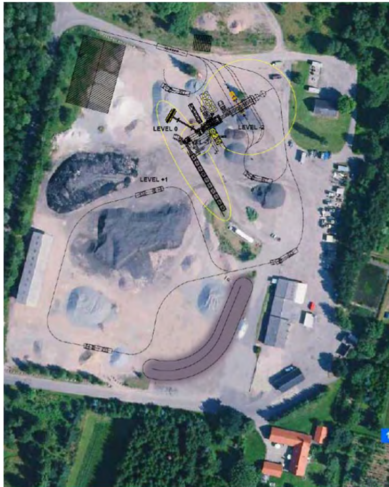
Figur 28 Asfaltanlægget med nærmeste nabo mod syd og den 4 m høje støjvold.
