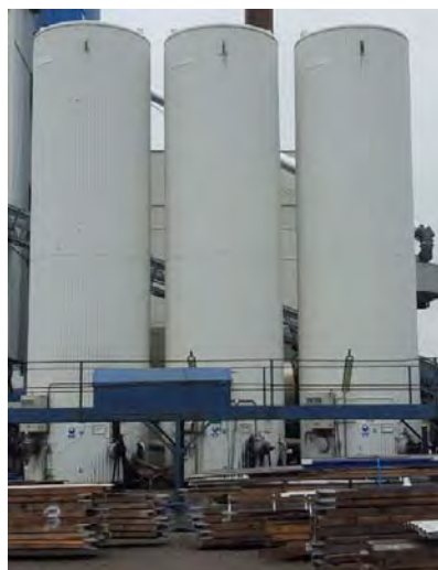
Figur 7 Bitumentanke fra nedlukket fabrik på Kometvej i Horsens.
