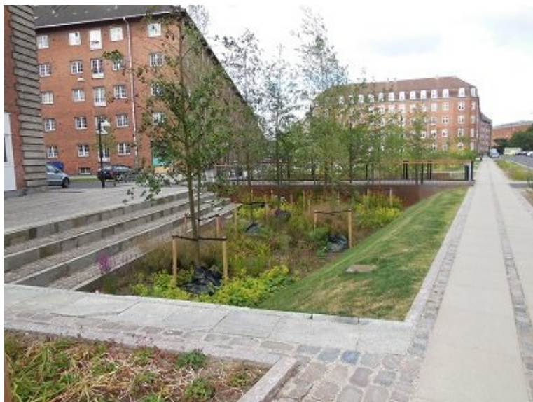
Eksempel på regnvandsbassin.
