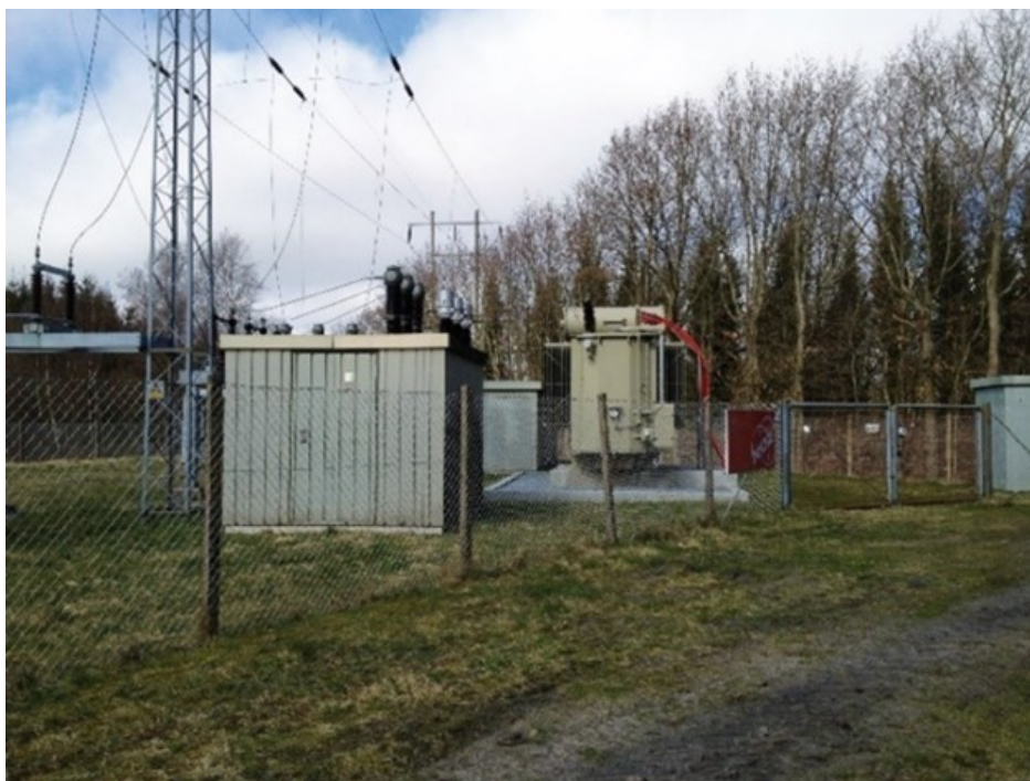
Eksempel på transformerstation med tilhørende master.
