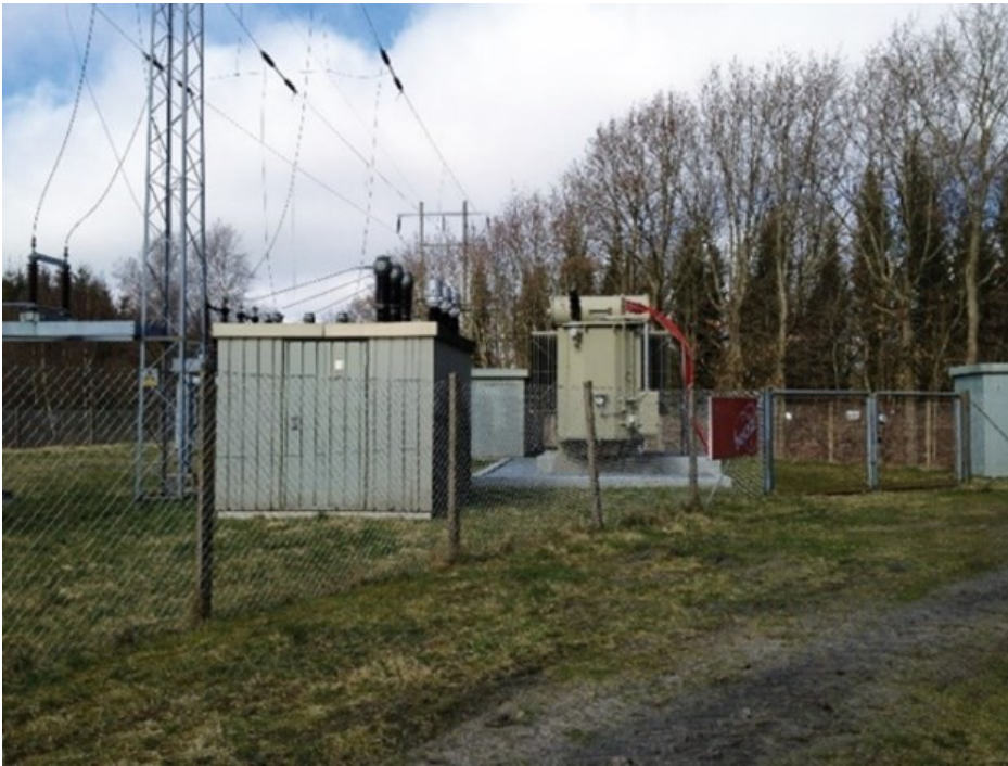
Eksempel på transformerstation med tilhørende master.
