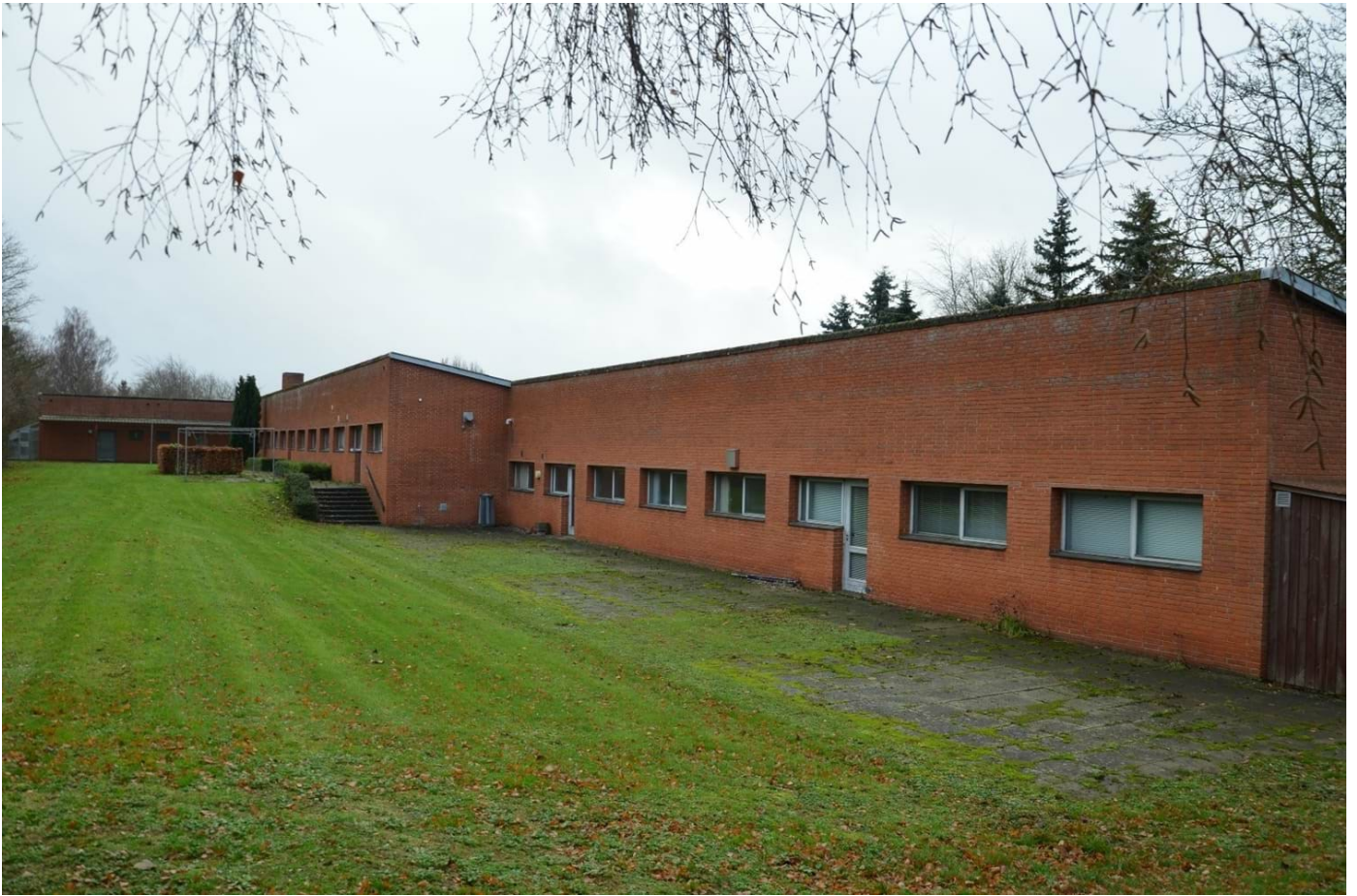
De bagvedliggende bygninger set fra nord mod syd.
