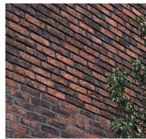
Eksempel på detalje i murværk med skift i fugefarve
