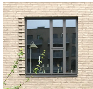
Eksempel på markering af vindue med murværksdetalje
