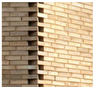
Eksempel på enkel murværksdetalje omkring hjørne
