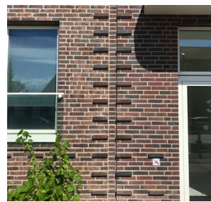
Eksempel på enkel murværksdetalje
