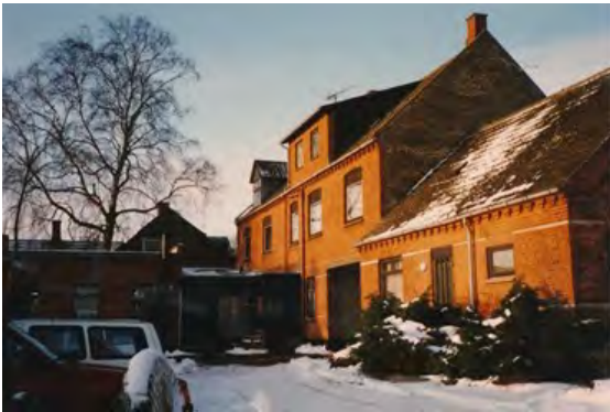
Billede af administrationsbygningen fra gården. Fra tiden, hvor der var taskekvist på taget.
