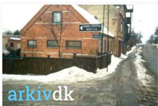
Administrationsbygningens østvendte gavl set fra Tølløsevej mod vest.
