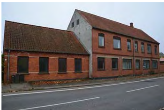
Administrationsbygningen som den fremstår i 2022.
