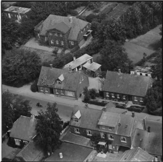
Luftfoto fra 1958 set fra syd, der viser administrationsbygningens gårdmiljø.
