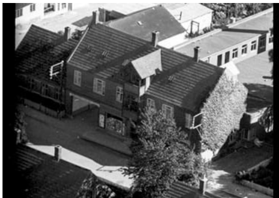
Administrationsbygningen set fra nord. En frontkvist, port og butiksvinduer mod Tølløsevej. På billedet ses de originale dannebrosvinduer.
