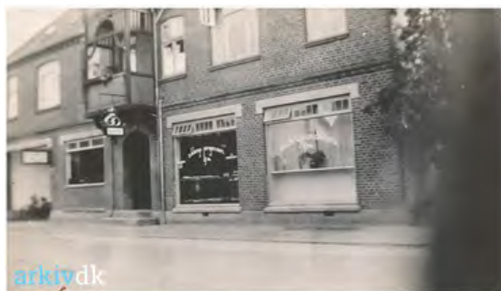
Fra 1937-38 bagerbutik, bygningen fremstår med betonoverligger og murværksdetaljer. Der har været dør ud mod vej og detaljeret altan på.
