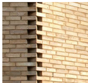
Eksempel på enkel murværksdetalje omkring hjørne
