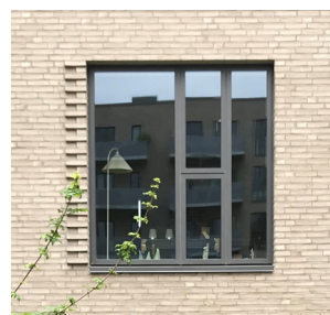
Eksempel på markering af vindue med murværksdetalje
