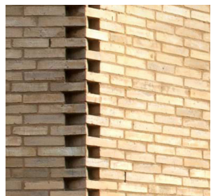
Eksempel på enkel murværksdetalje omkring hjørne
