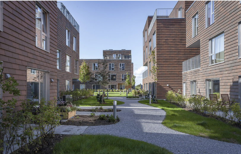
Nordrefælled Kvarter, ONV Facader med skærmtegl
