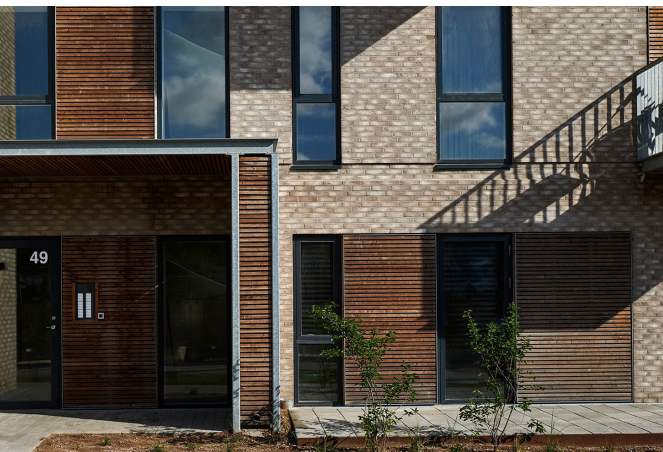
Vølunden, Kullegaard Facader i tegl med partier i træ
