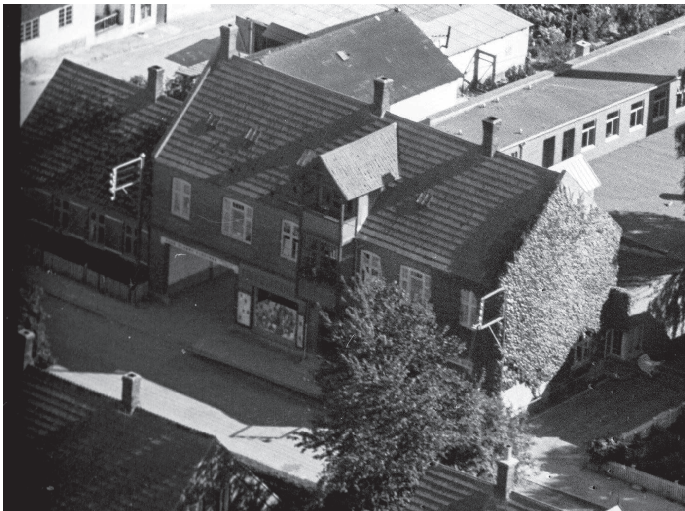
Administrationsbygningen set fra nord. En frontkvist, port og butiksvinduer mod Tølløsevej. På billedet ses de originale dannebrosvinduer.
