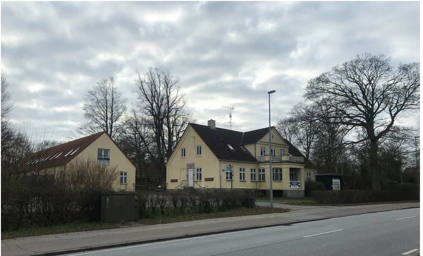
Hovedhuset og længebygningen set fra Kalundborgvej som det står i dag.
