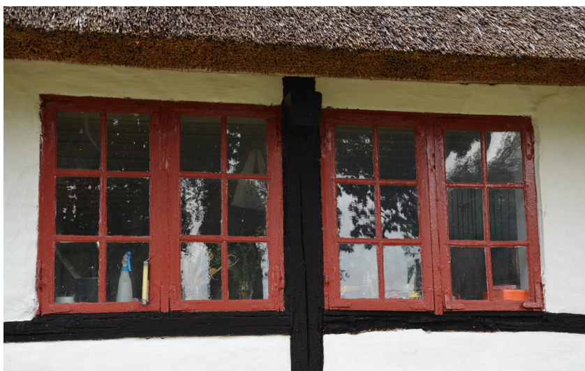
Originale vinduer med enkeltlagsglas og kitfals
