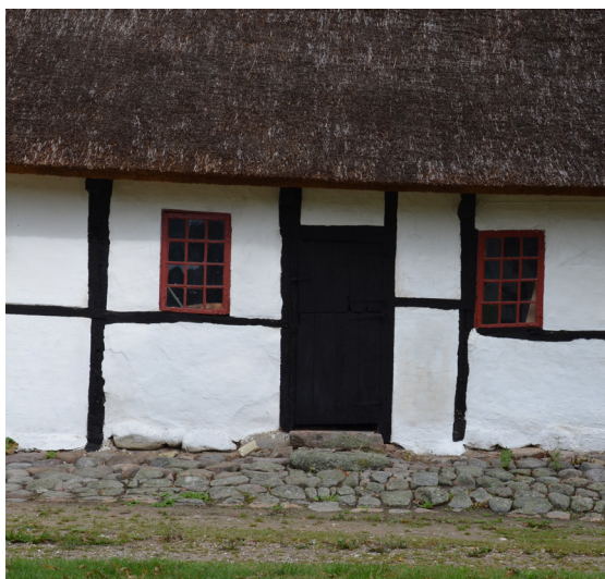
Originale vinduer, døre, trappe og pigstensbelægning
