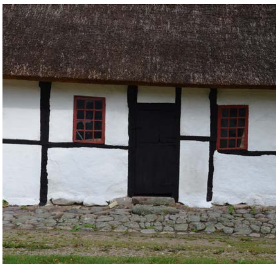
Originale vinduer, døre, trappe og pigstensbelægning
