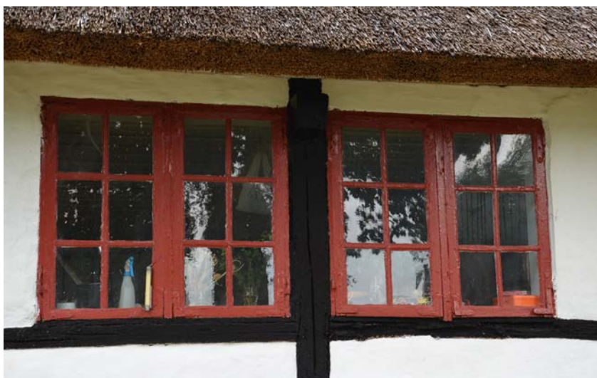
Originale vinduer med enkeltlagsglas og kitfals
