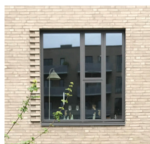
Eksempel på markering af vindue med murværksdetalje
