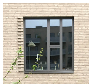
Eksempel på markering af vindue med murværksdetalje
