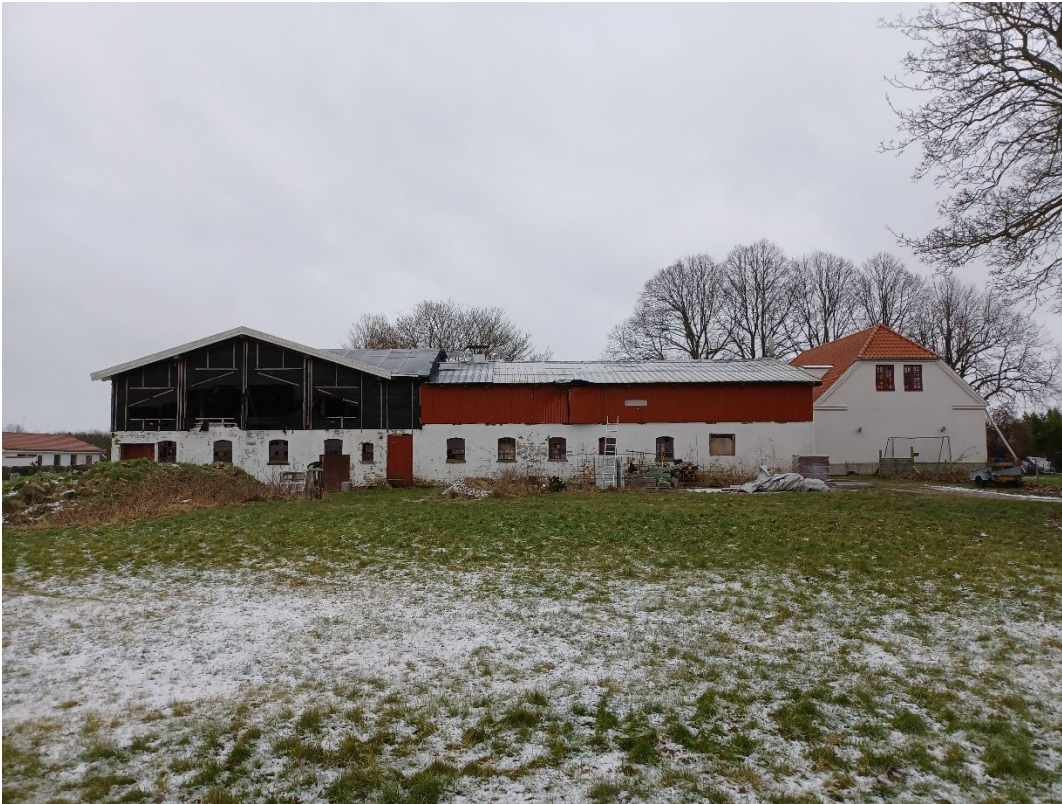
Vestlig længe set fra ydersiden/ejendomsskel
