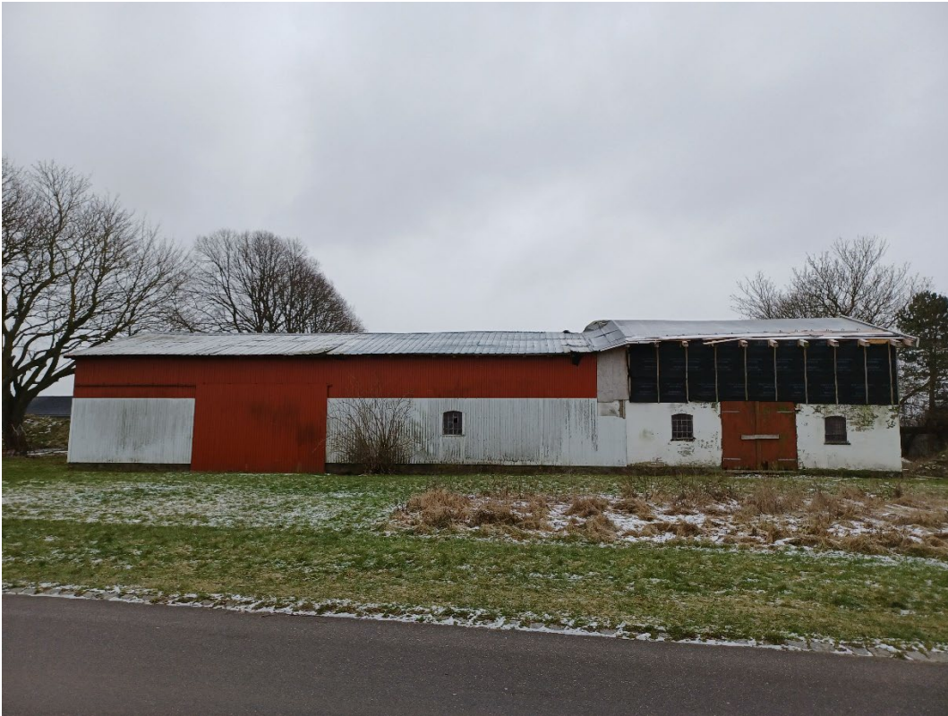
Nordlig længe set fra ydersiden/ejendomsskel
