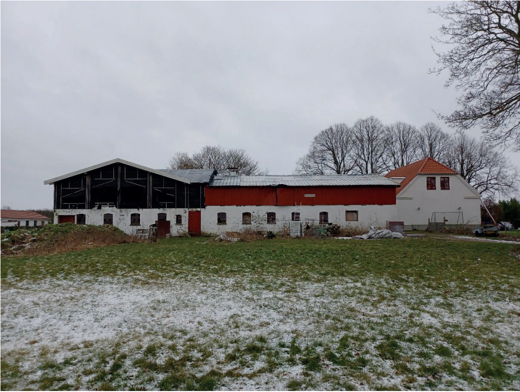
Vestlig længe set fra ydersiden/ejendomsskel
