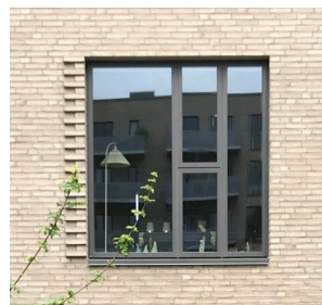
Eksempel på markering af vindue med murværksdetalje
