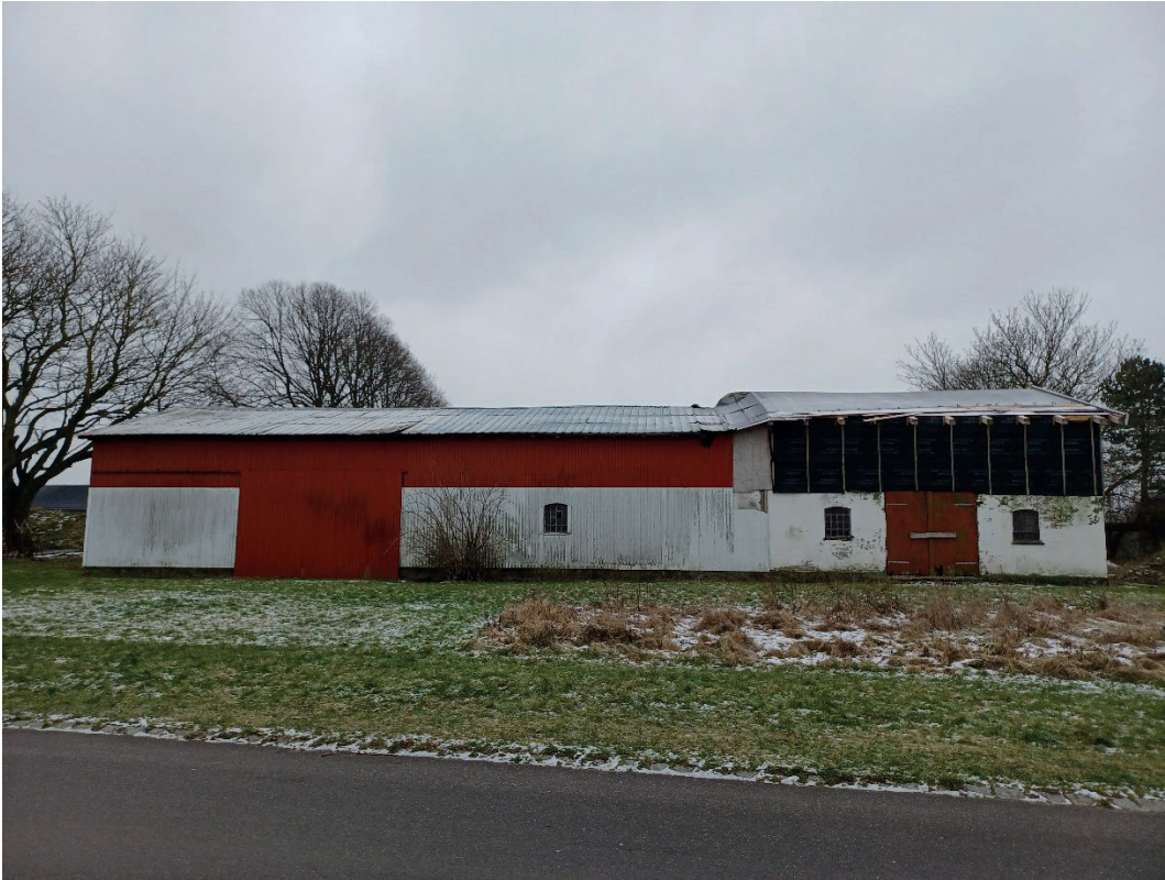
Nordlig længe set fra ydersiden/ejendomsskel
