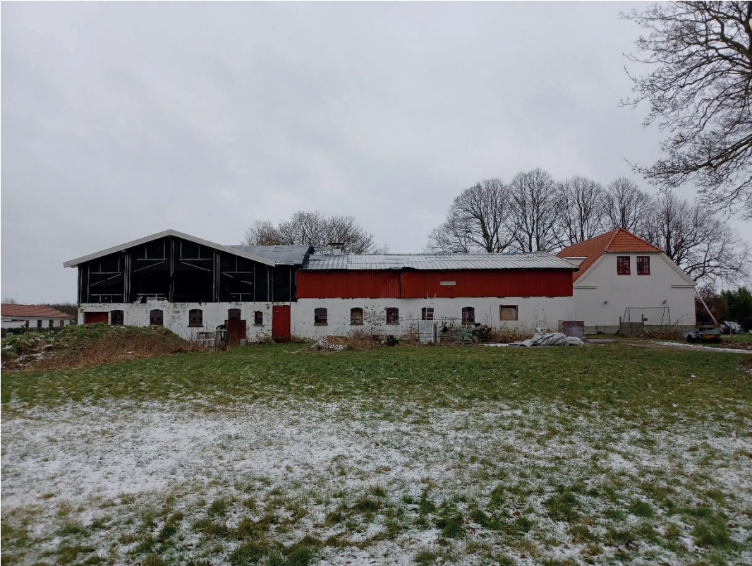
Vestlig længe set fra ydersiden/ejendomsskel
