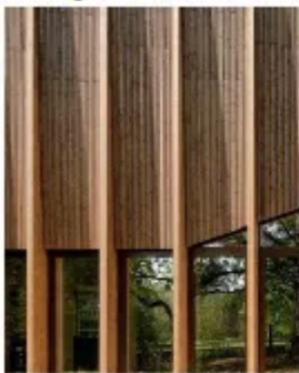
Træfacade med begrænset mængde glas
