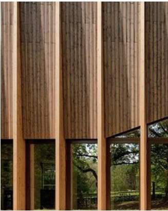
Træfacade med begrænset mængde glas
